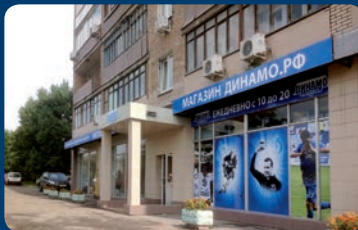
Москва, ул. Новая Башиловка, д. 8
