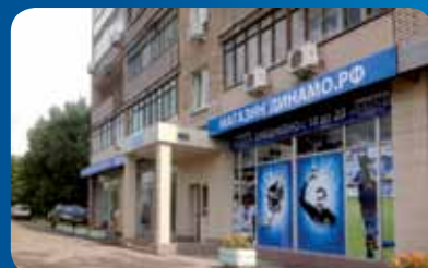
Москва, ул. Новая Башиловка, д. 8
