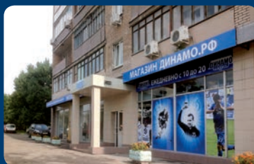
Москва, ул. Новая Башиловка, д. 8
