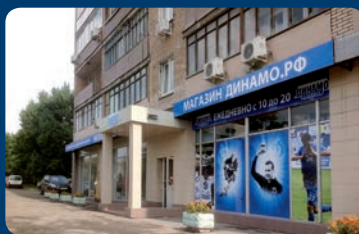
Москва, ул. Новая Башиловка, д. 8
